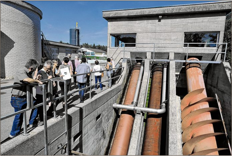
La station d'épuration de Romont traite les eaux usées de 12 000 personnes. VINCENT MURITH
